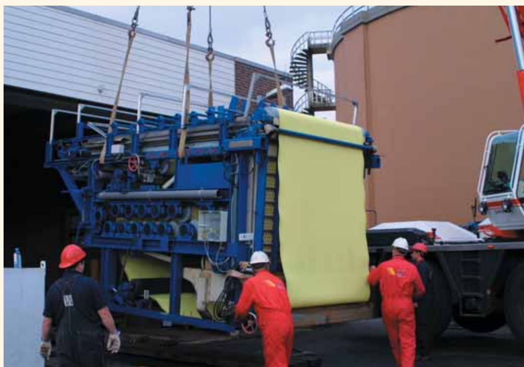
Gerenoverde machine wordt naar binnen getakeld.
